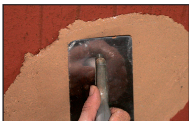
Étape 1 - application directe sur brique plâtrière légèrement humidifiée (pas de sous couche de fond ou d'accroche)
