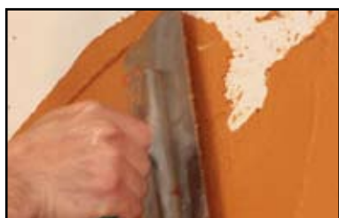
Etape 3 - application de l'enduit en 3mm à l'aide d'une spatule inox.
