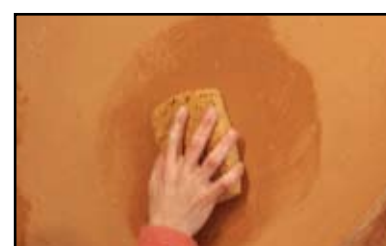
Etape 5 - une fois l'enduit sec, passage d'une éponge semi-humide afin de faire tomber les poussières de surface et faire ressortir le lin.
